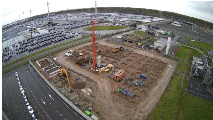
Figuur 2.1: Hyoffwind in Zeebrugge in aanbouw
